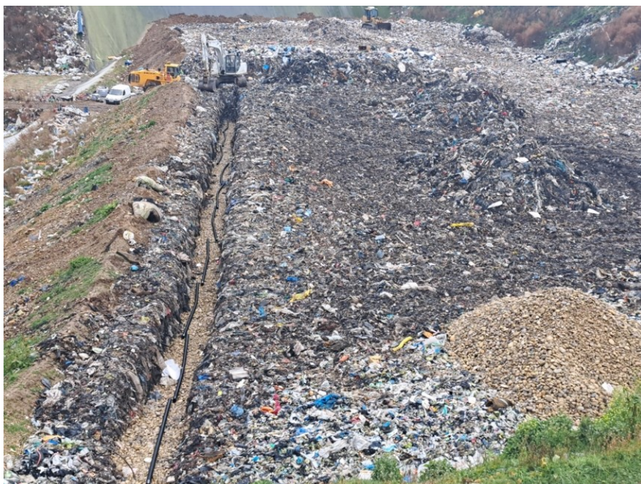
Réalisation et raccordement de la tranchée drainante TD4"
