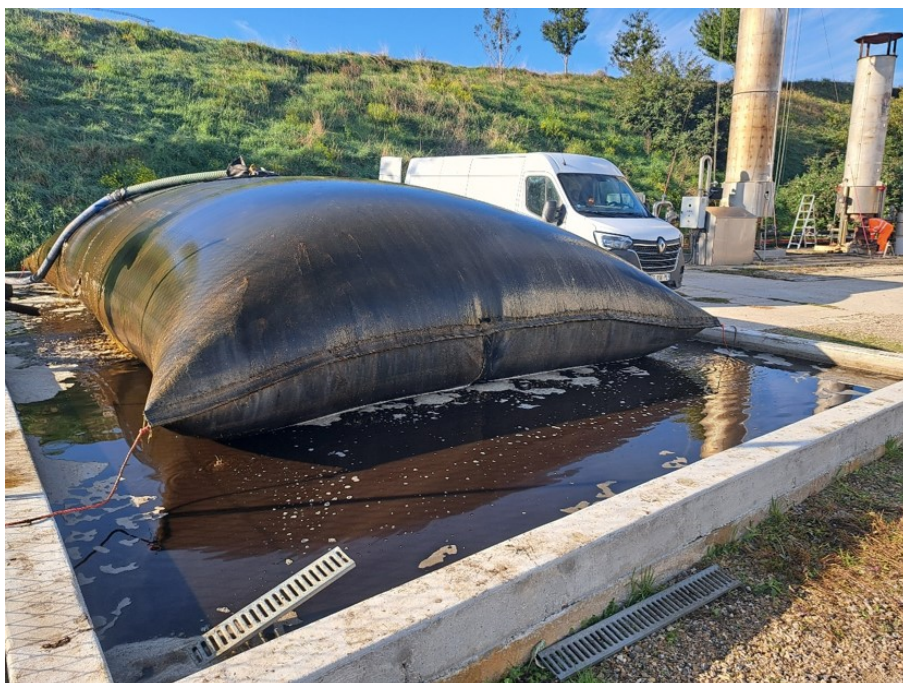
Fin de remplissage du géotube et début de séchage
